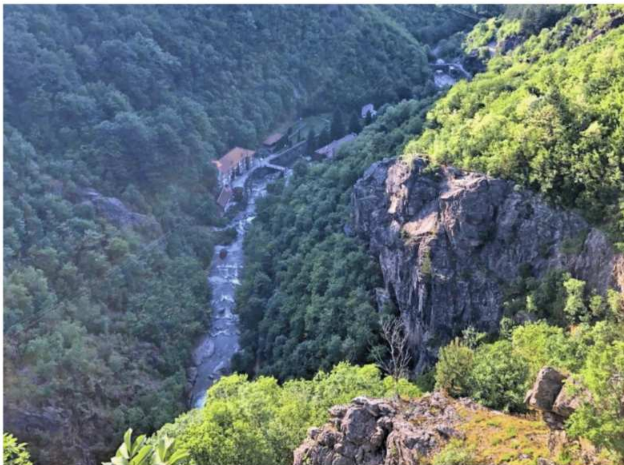
Слика 4. Поглед са видиковца поред државног пута на машинску зграду мале хидроелектране „Вучје” у режиму заштите трећег степена, фото: И. Меденица
